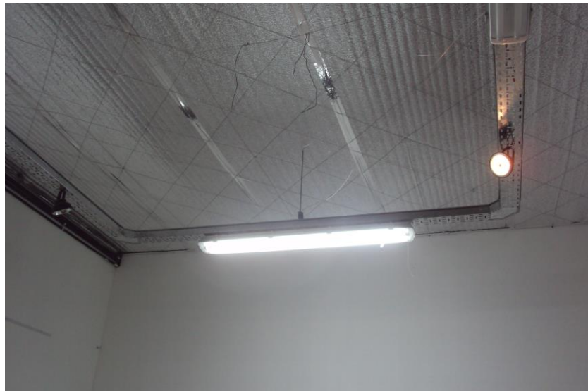
Bandeja que pende del techo del aula, la cual utilizaría para instalar el soporte de los proyectores.
