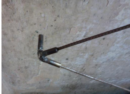
Detalle de la pieza utilizada para unir las varillas.
